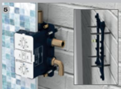
Positionieren Sie den FirUnico®-Einbaukörper auf den an der Wand angebrachten 4 Gewindestangen; regulieren Sie die Tiefe mit den entsprechenden Muttern; vergewissern Sie sich, dass sich die Verkleidung zwischen MIN und MAX befindet und nehmen Sie erneut eine Nivellierung mit der Wasserwaage vor.
