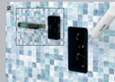
Trennen Sie den Teil des FirUnico®-Gehäuses ab, der aus der Mauer herausragt und versiegeln Sie den Zwischenraum zwischen Gehäuse und Mauer mit Silikon.
