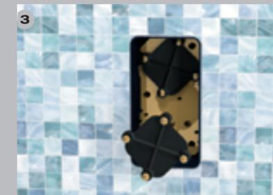
Schrauben Sie die untere Kappe ab, die sich auf Höhe der Warm- und Kaltwasserausgänge des FirUnico®-Einbaukörpers befindet.
