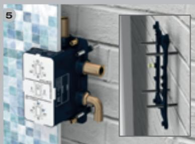
5 Posizionate l'incasso FirUnico® sui 4 tiranti applicati al muro, regolate la profondità agendo sui relativi dadi assicurandovi che il rivestimento sia compreso tra MIN e MAX ed effettuate nuovamente la messa in bolla.
